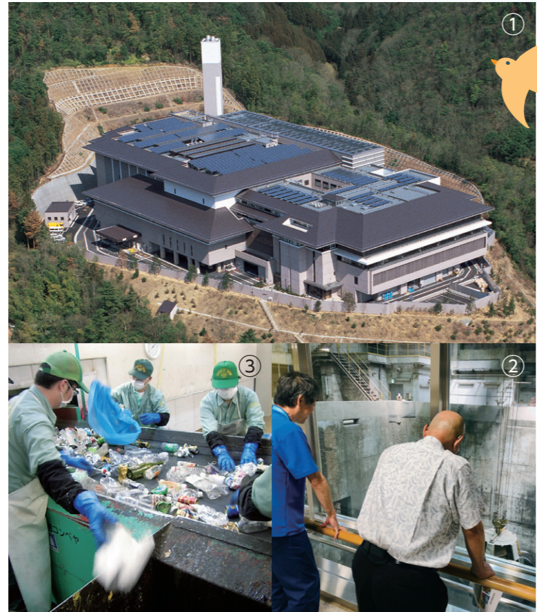
① 京都市北部クリーンセンター ② 資源ごみ運搬の様子を視察(矢野理事長) ③ 不適物などの手選別
