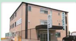
洛和グループホーム西ノ京 京都市中京区西ノ京冷泉町140 TEL 075(813)5720
