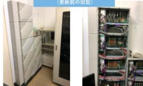
写真は記念HPの壁付け型PBX （更新前の旧型）
